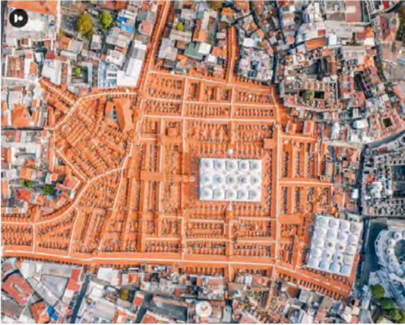
Şekil 1: Kapalıçarşı çatısına ait hava fotoğrafı (Gzt, 2020)
